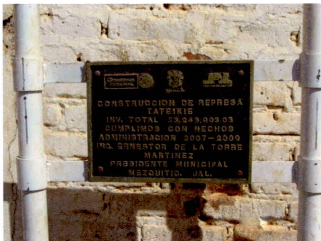
Foto 17, 2010: Torres Contreras. La construcción de la represa que iba a solucionar el problema del agua en San Andrés, pero salieron mal los cálculos de suelo y la represa quedó empezada. Y puede ser que a corto plazo no se solucione.
