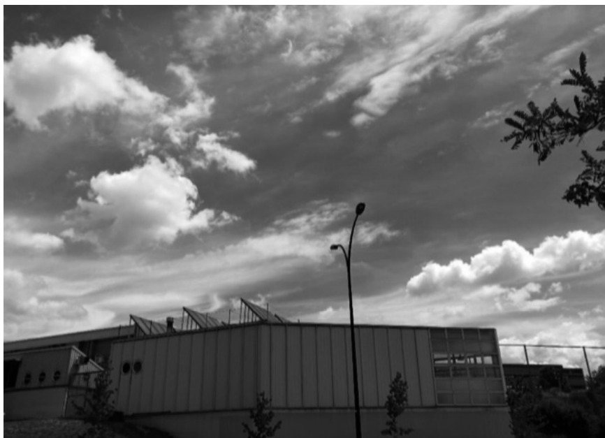
Figura 10. Instalaciones deportivas con calentadores solares de agua en la UAB
