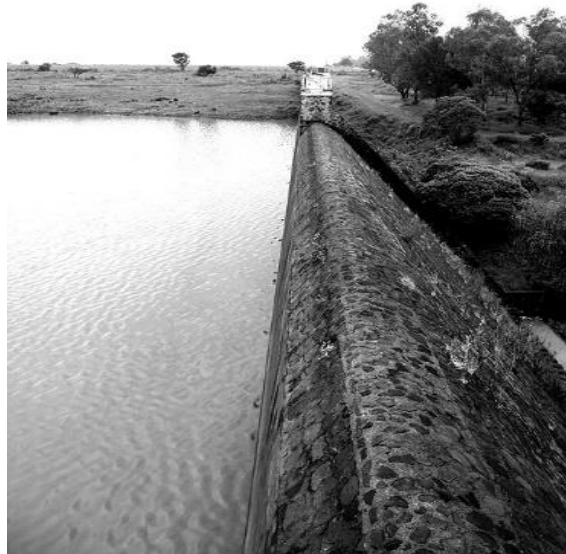
Vista parcial de la presa El Jihuite.
