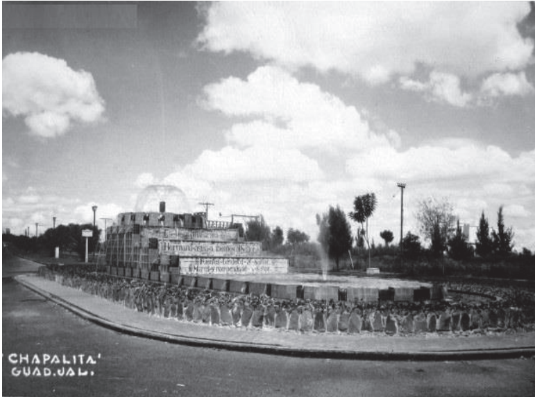
Fotografía 8. Fuente original La Hermana Agua
