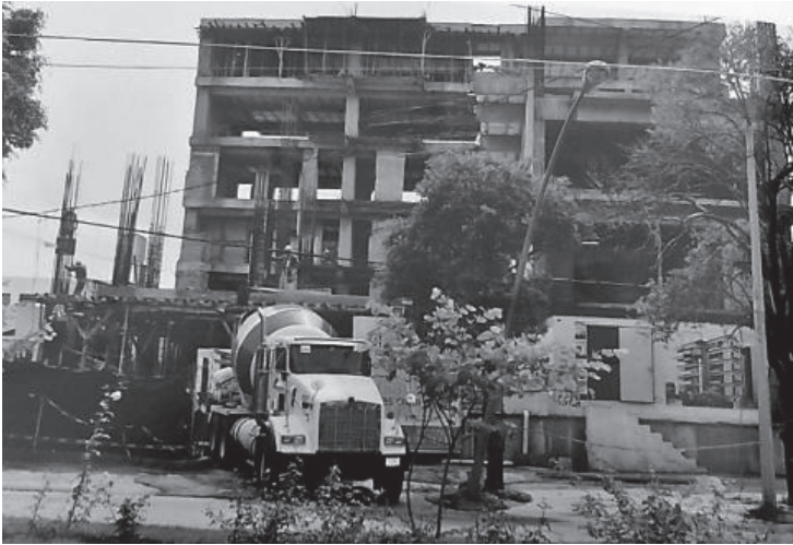
Fotografía 16. La Torre DUE en construcción
