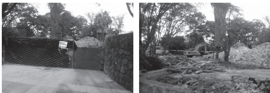
Fotografía 19. Escombros de la antigua casa de la familia Aguilar luego de su demolición
