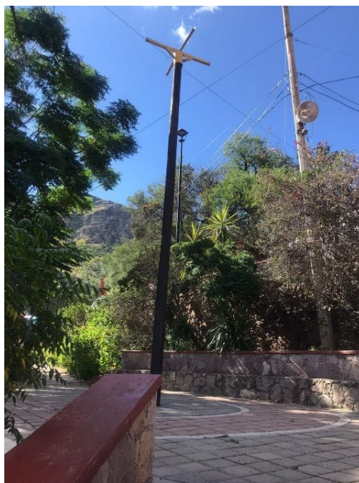
Figura 5. Estructura para el Palo encebado
