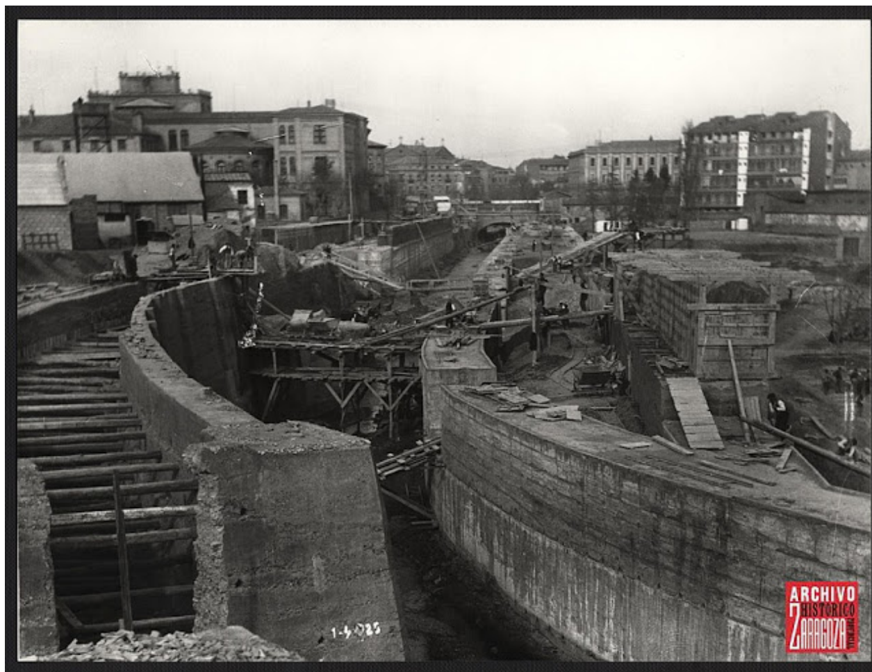
Figura 3. Imagen de las obras de cubrición del río Huerva en Zaragoza (1925)
