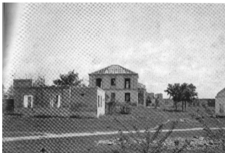
Figura 2. Viviendas cercanas a la Osa Mayor
