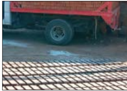
Vehículo de tres toneladas con tres mil ladrillos de bóveda.
