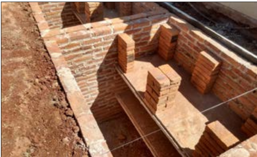
Esta imagen muestra el avance en las tumbas de las cuales José de Jesús Palo Rodríguez fue encargado de construir.
