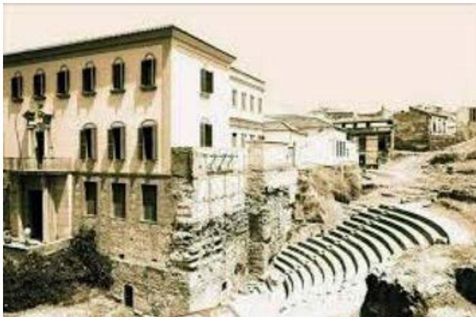
Figura 8.. La Casa de la Cultura (1951-1995) construida sobre el Teatro Romano
