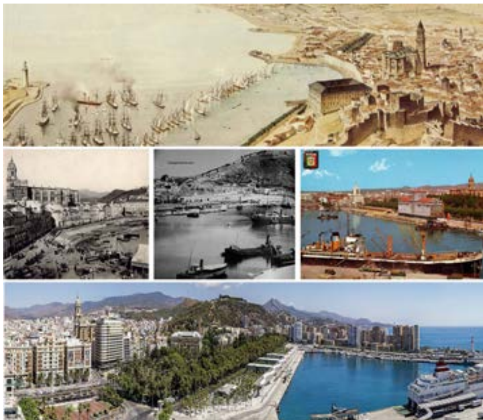
Figura 6. Composición fotográfica diversas épocas Puerto de Málaga.
