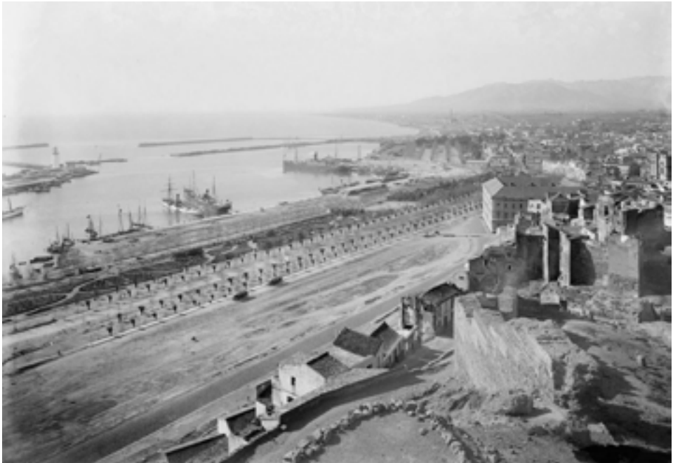
Figura 3. Obras construcción del Parque de Málaga, hacia 1910.
